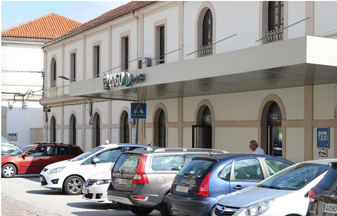
Fig. Estación de trens de Lugo (exterior)
