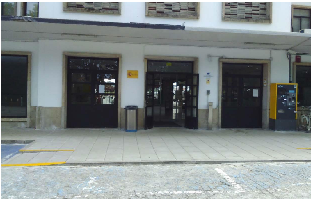
Fig. Entrada á estación de trens de Ferrol sen sinalizar.
