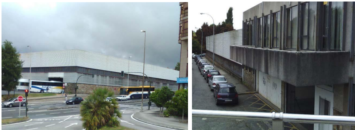
Figs. Estación de autobuses de Santiago de Compostela (exteriores sen letreiro)
