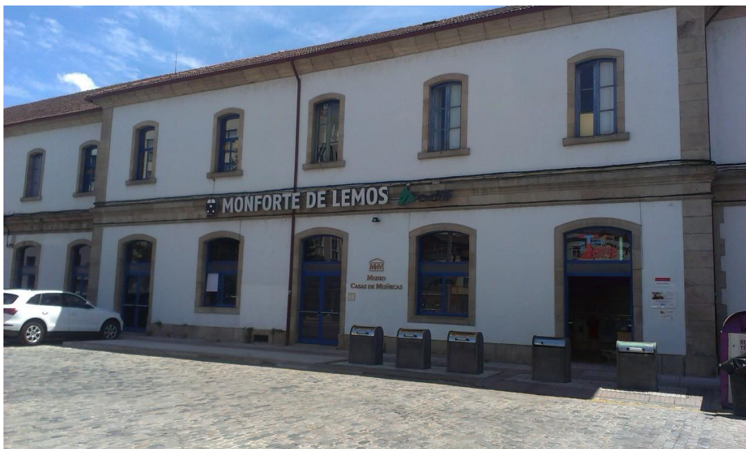
Fig. Entrada principal da estación de trens de Monforte de Lemos.
