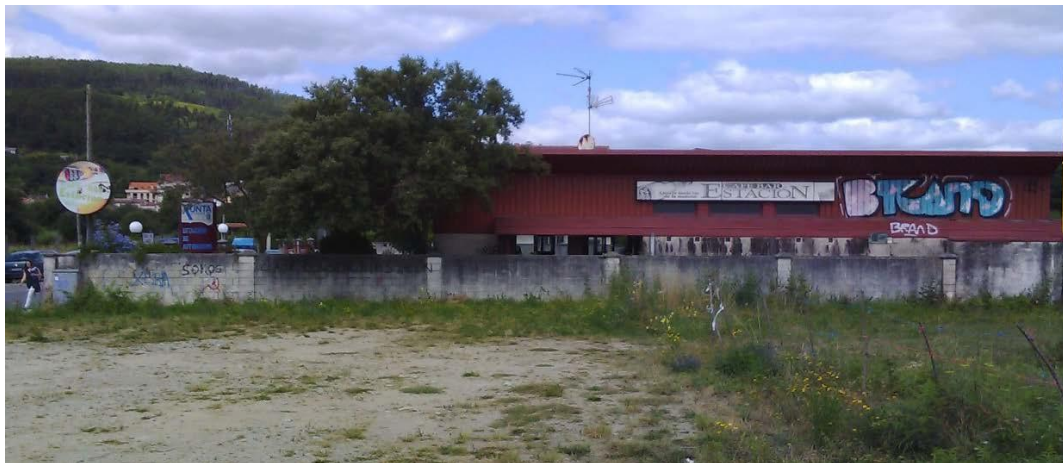
Fig. Estación de autobuses de Padrón (lateral estrada N-550)
