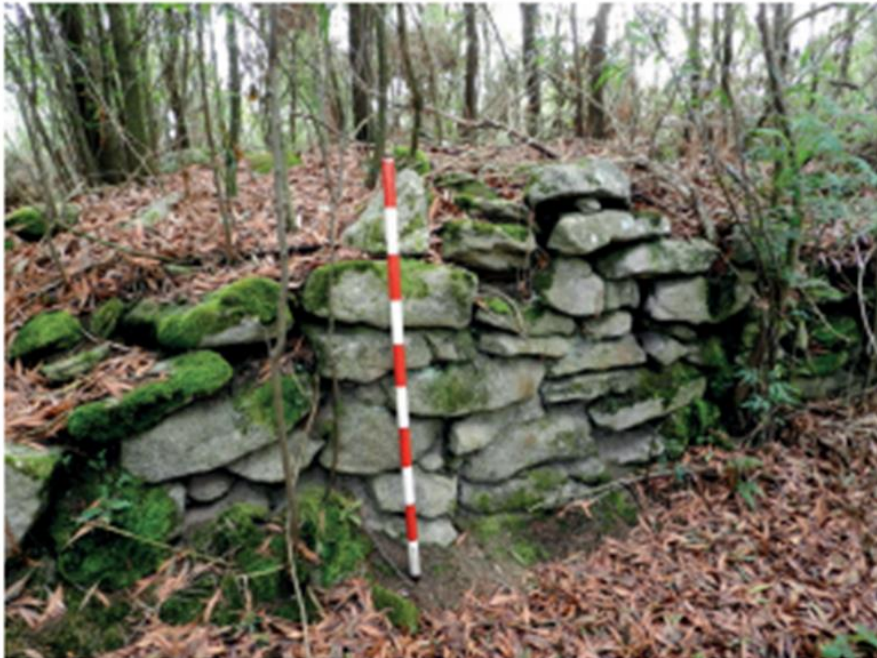
Figura 6 Detalle del lienzo masonry en el sector noreste del Castro Valente
